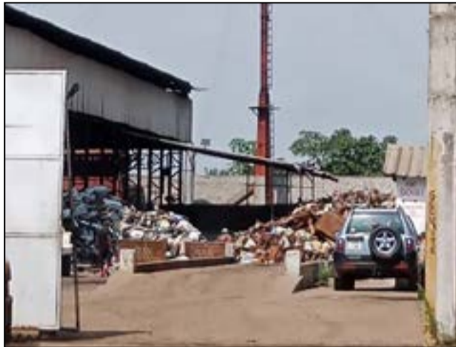
L'entrée de l'usine de la société Metssa Congo, à Pointe-Noire.
